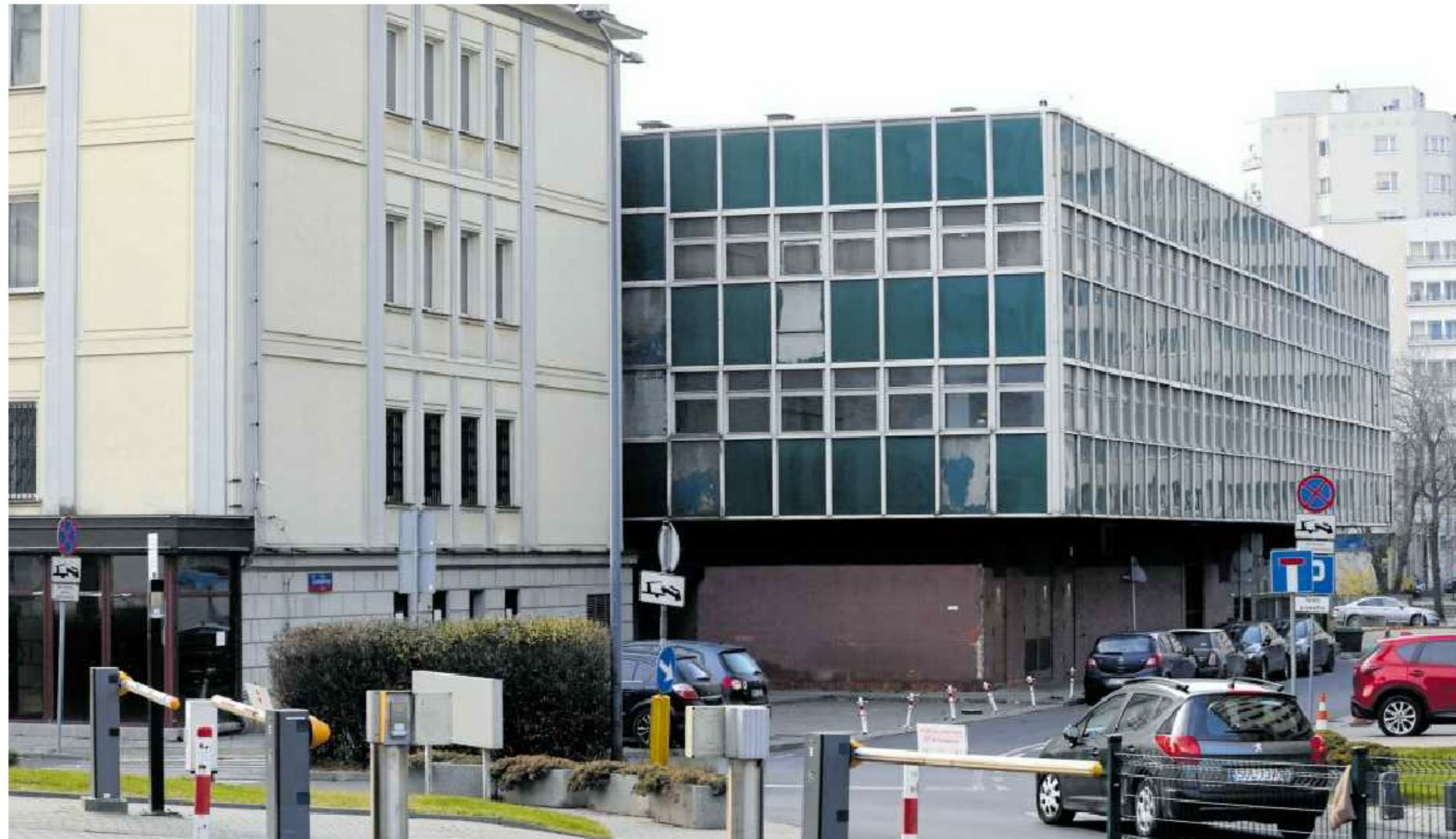
• Dawna siedziba Teatru Dramatycznego przy ul. Kasprzaka 22. Z prawej dobudowany do niej pawilon z lat 70.
